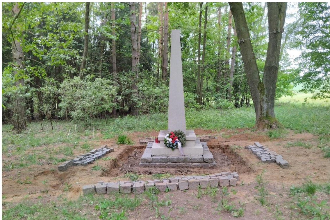
Obrázek 12: Celkový zadní pohled na nový výkop pro nové podloží pod dlažbu a obruby.
