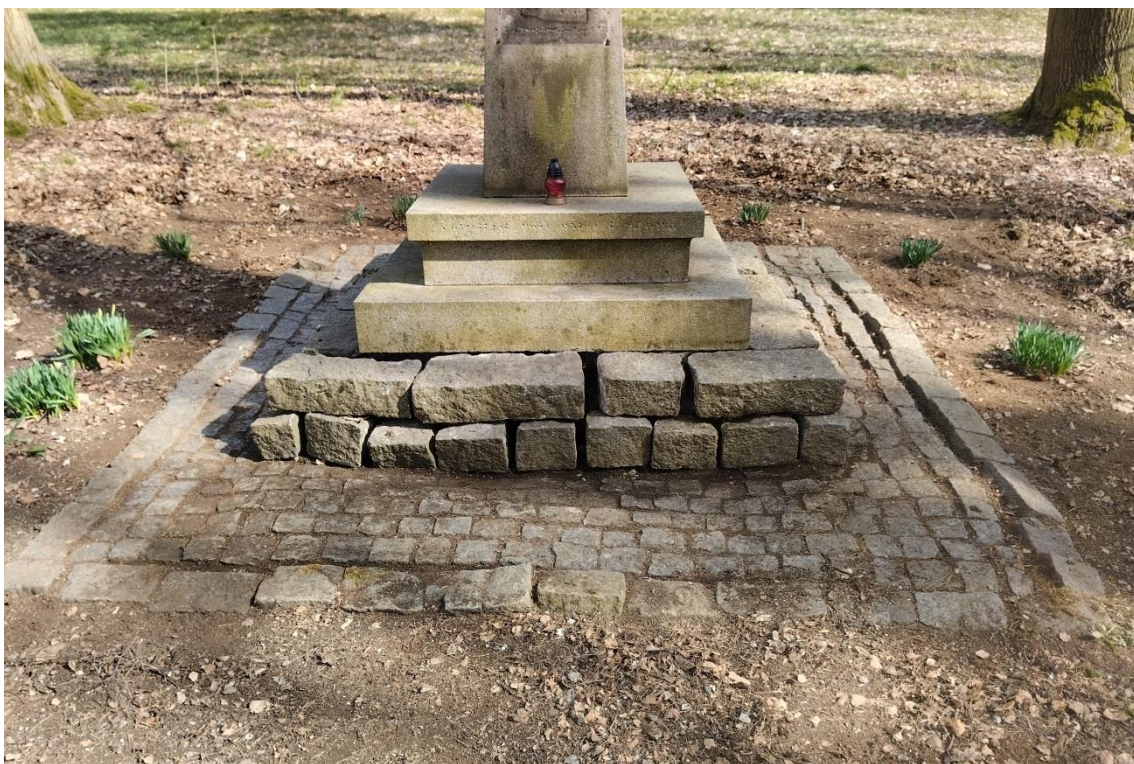
Obrázek 7: Detailní pohled na odspárovanou kamennou podezdívku a vyvrácené obruby.
