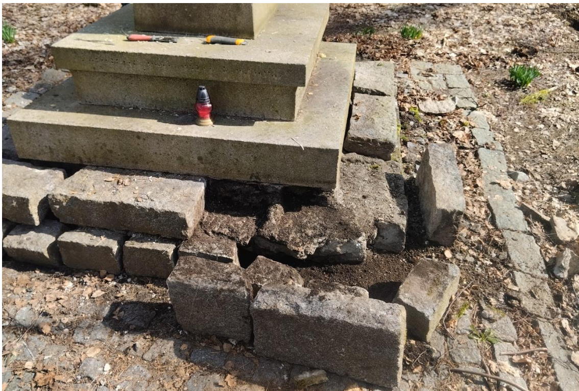
Obrázek 8: Pohled na přezdívání štípaných kamenů ve schodové podezdívce.
