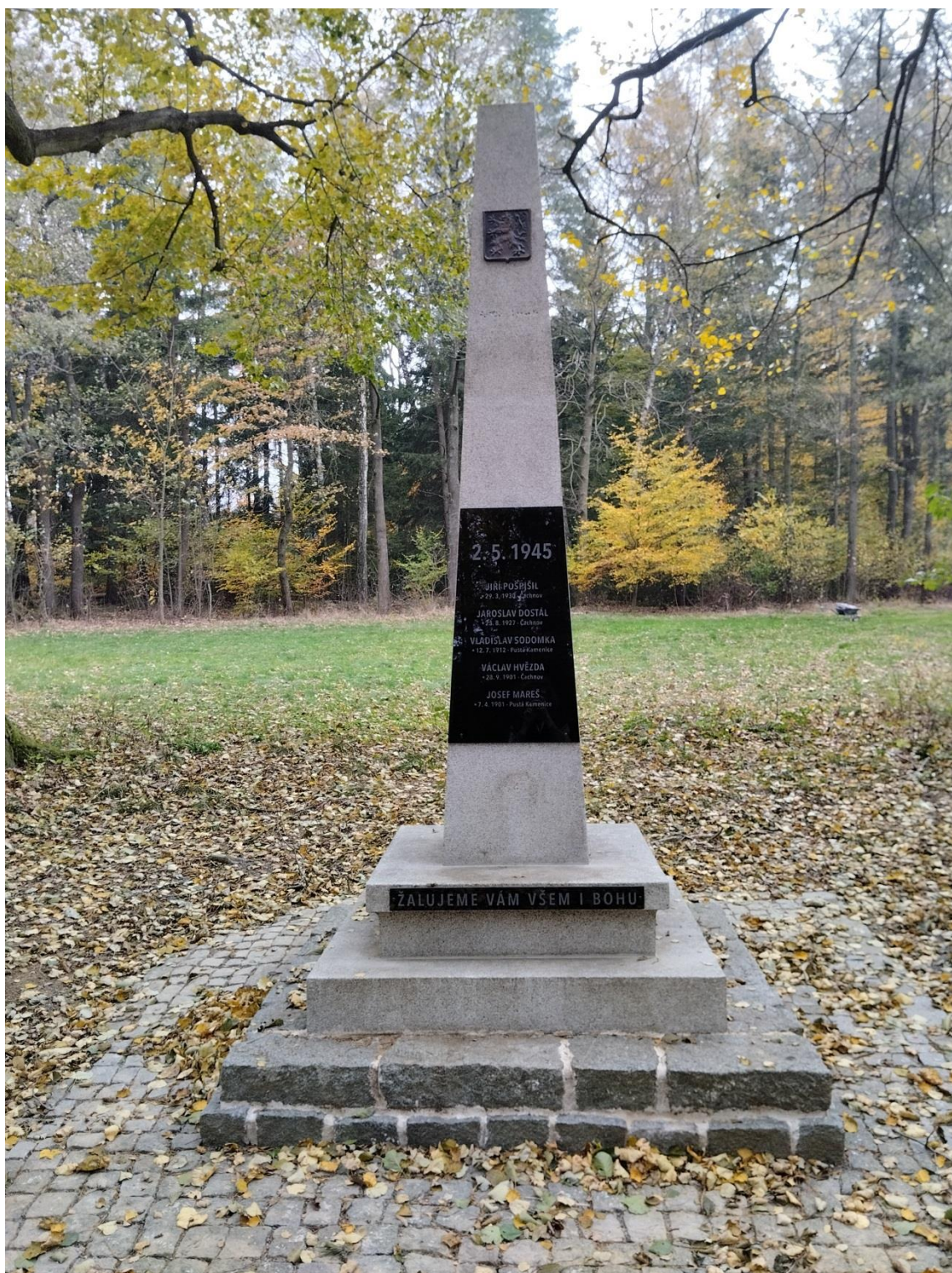
Obrázek 19: Celkový čelní pohled, stav po restaurování.
