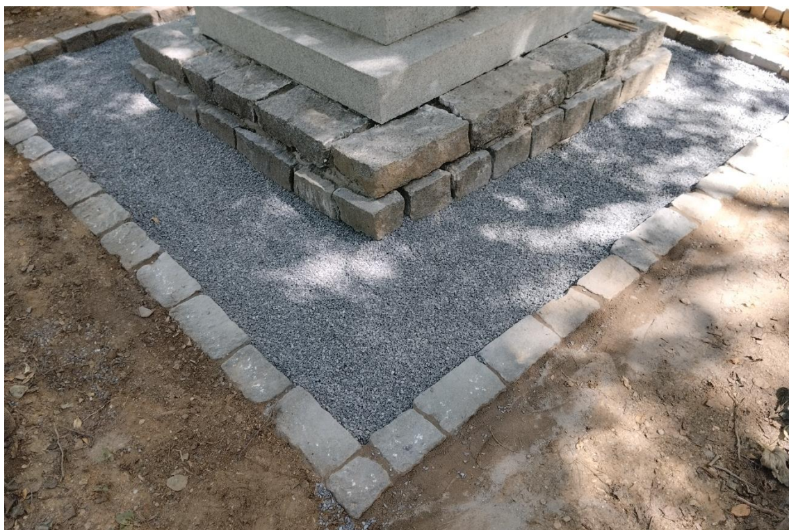
Obrázek 13: Pohled na obruby uložené do betonu a jemnou drť pod dlažbu.
