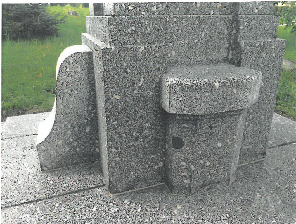
Foto č. 17 – Průběh restaurování – celkové očištění pomníku
