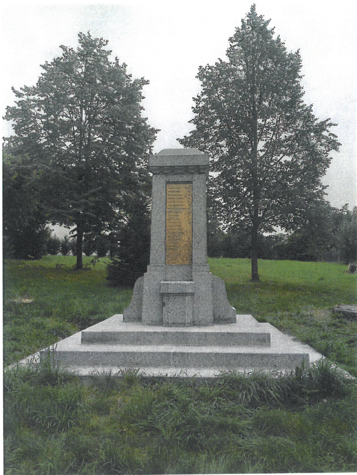
Foto č. 20 – Stav po restaurování – celkový pohled
