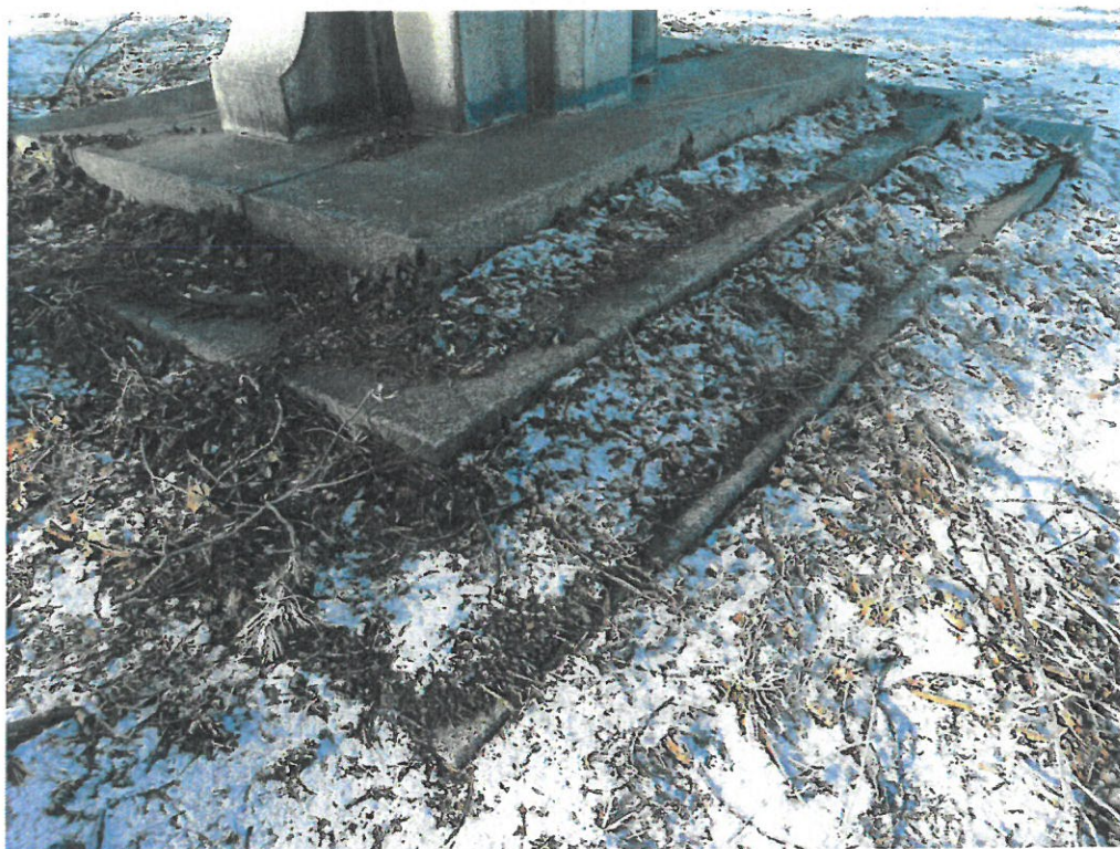
Foto č. 13 – Stav před restaurováním - schodišťové stupně silně znečištěny porostem – přední pravý roh
