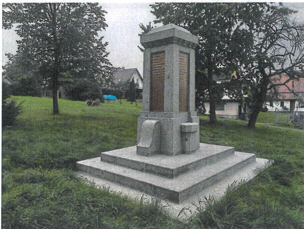
Foto č. 23 – Stav po restaurování – celkový pohled
