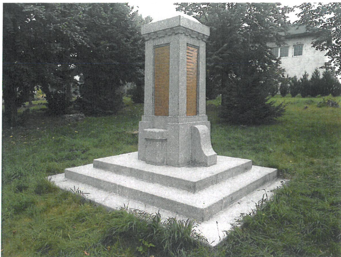
Foto č. 24 – Stav po restaurování – celkový pohled
